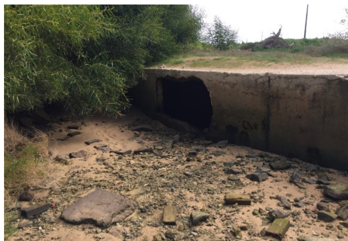
Fotografias 8 e 9 – Galeria em betão com seção retangular fechada e abertura lateral executada na zona de confluência com a vala (as setas indicam a direção e o sentido do escoamento ao longo da vale e da galeria não havendo influência da maré).
