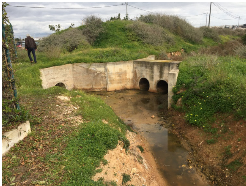
Fotografia 14 – Vista de montante para jusante das duas entradas obturadas com comportas de não retorno. Do lado esquerdo, descarga para a vala.
